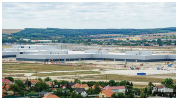
Pohľad na výstavbu závodu v Priemyselnom parku Nitra-Sever, Dolné Hony. - Autor: SITA, Martin Havran
